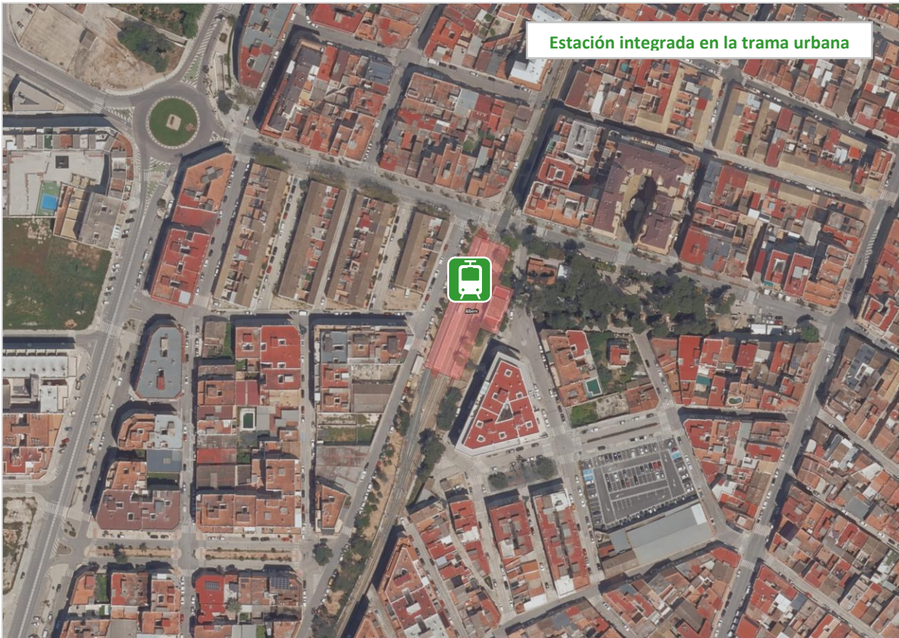
Figura 21. Estación ferrocarril Alberic Fuente: Elaboración propia.
