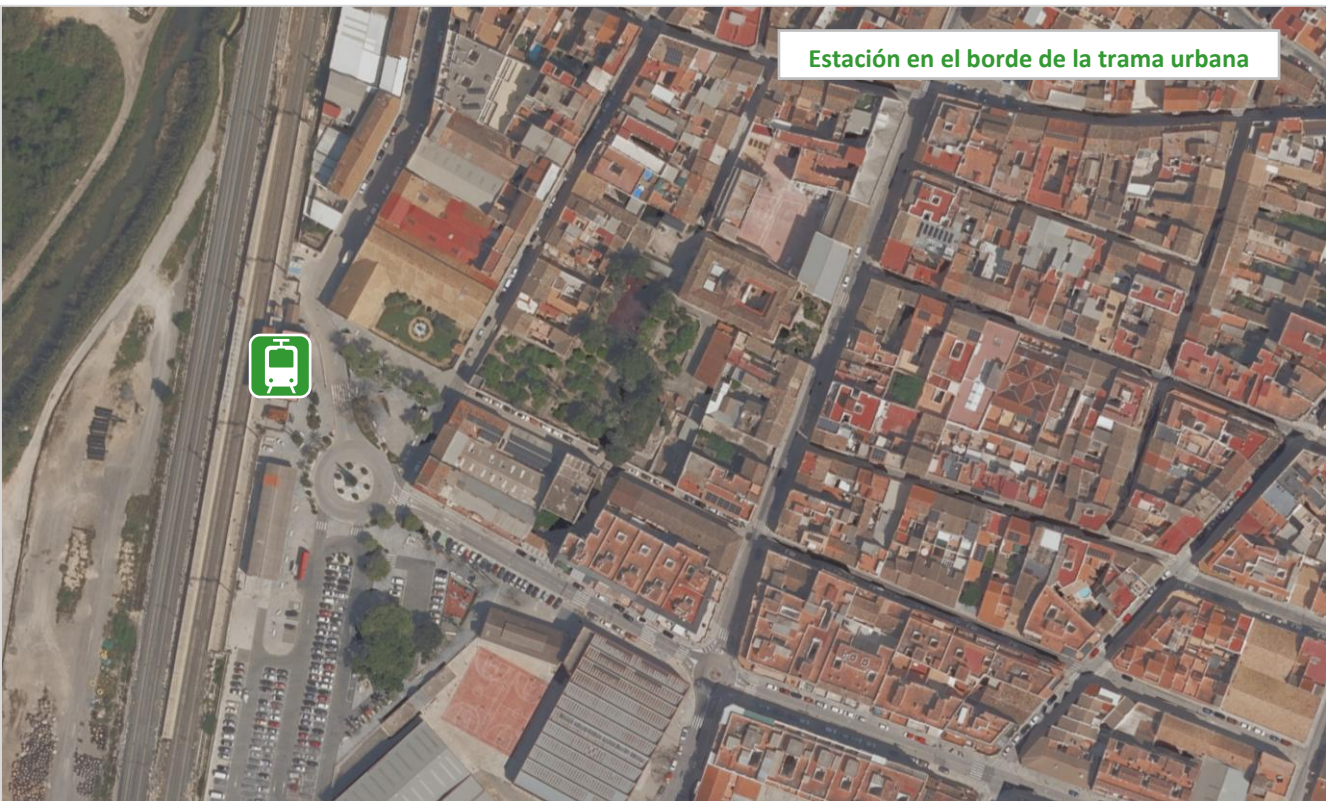
Figura 22. Estación ferrocarril Carcaixent Fuente: Elaboración propia.
